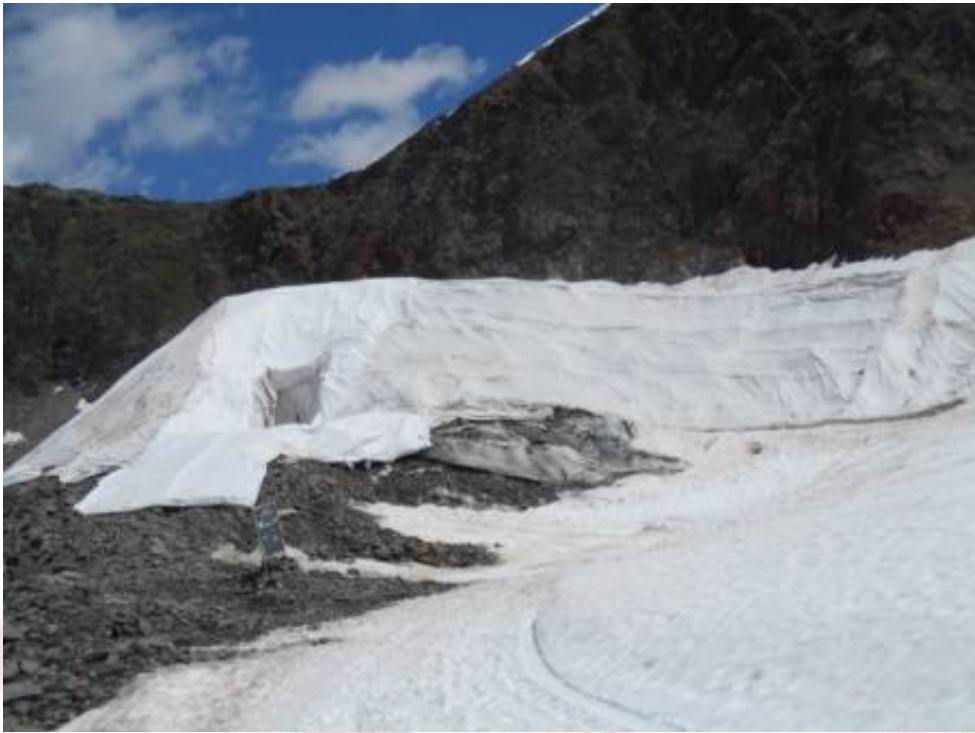
Der abgedeckte Gletscher mit dem Eingang zum Tunnel
